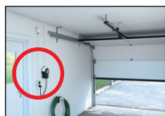
På väggen intill utgångsdörren
